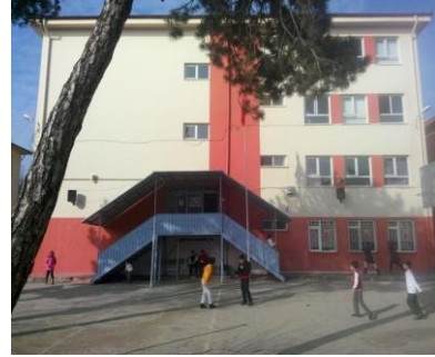
İkinci Bina Arkadan Görünüş
